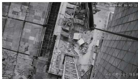
图 6 塔吊吊钩可视化画面
