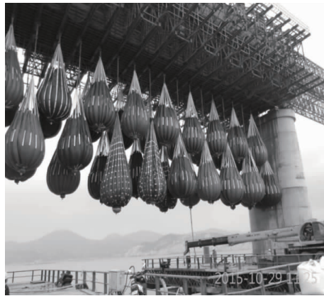
图7 移动模架吊袋预压
