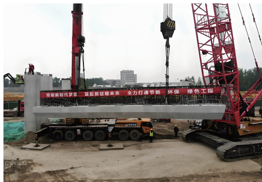
图3 分层预制盖梁施工现场
