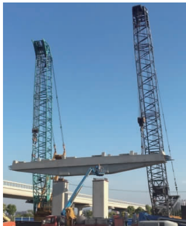
图2 整体预制盖梁现场吊装
