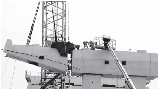
(b)干接法 图 5 分段预制盖梁
