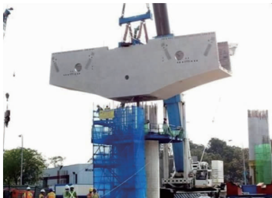
图4 预制盖梁“外壳”
