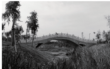
图 13 9 号桥焕然河桥实景图
