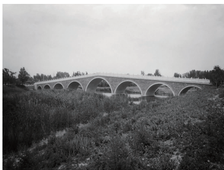
图 11 4 号桥虹石桥实景图
