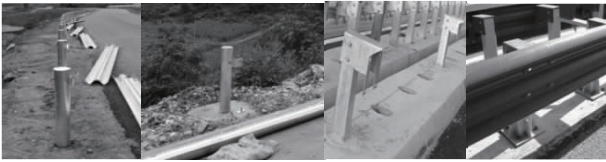
图 12 波形梁护栏立柱埋置方式图示
