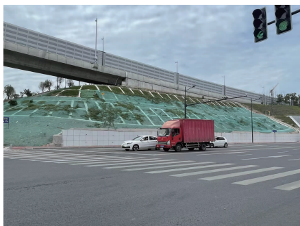
图9 完工后的锚杆-框格梁防护照片
