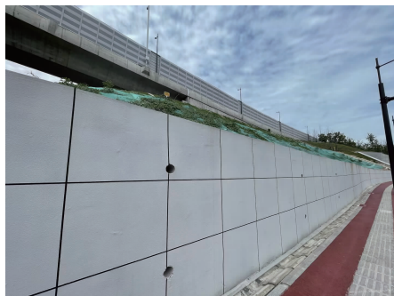
图10 完工后的桩板墙防护照片
