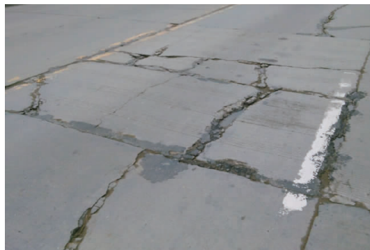
图 1 破碎板之实景
