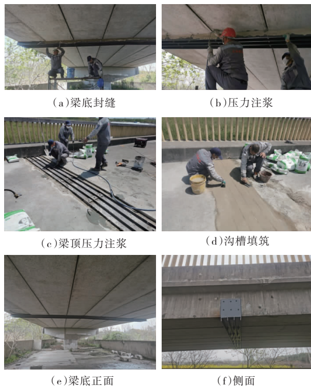
图 3 黄赵路跨线桥工艺试验施工照片
