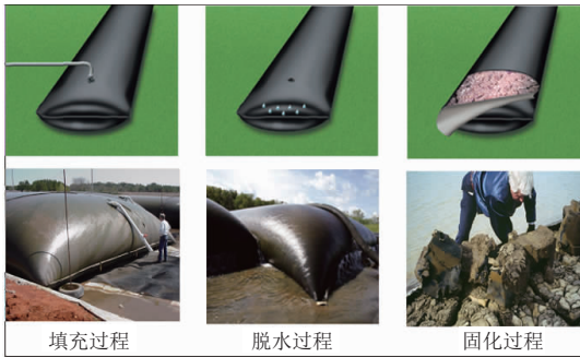
图 12 生态土管袋处置过程
