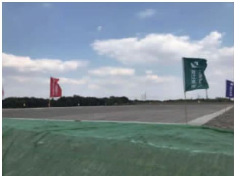
图 5 堆场建设完成(2018.10)
