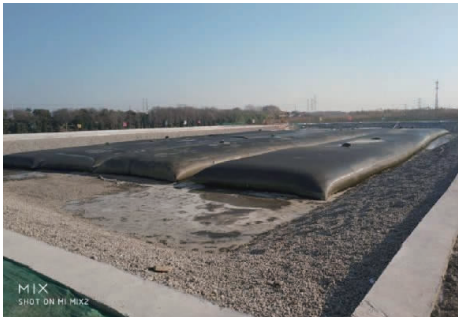
图 10 管袋充填完毕进入固结期(2019.01)
