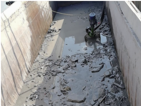
图 8 仓内吹填完毕后残余垃圾情况(2018.11)
