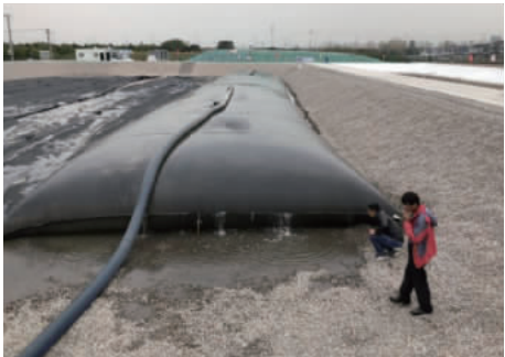
图 7 生态土管袋充填并沥出水(2018.11)
