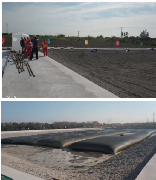
图1 苏四期底泥中试堆场建设
