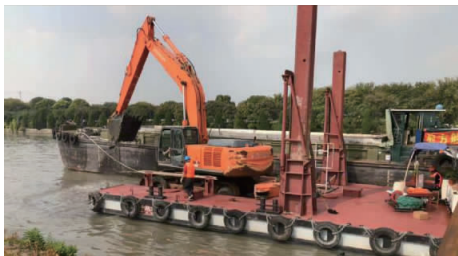
图 6 抓斗式挖泥船正在区作业(2018.11)
