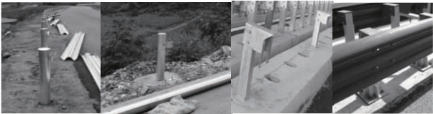
图 12 波形梁护栏立柱埋置方式图示
