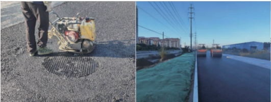
图 8 井盖周边沥青施工之实景
