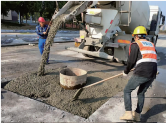
图 6 卸荷板浇筑之实景
