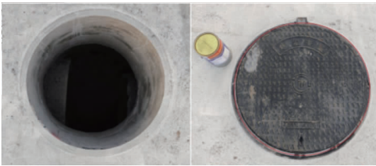
图 7 卸荷板井盖安装槽及井盖安装之实景
