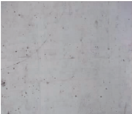
图 11 胶合板模板浇筑面
