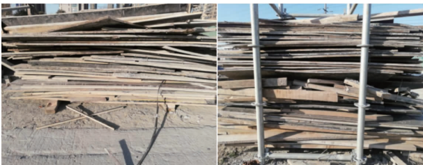
图 3 破损模板
