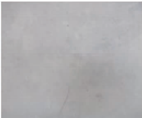
图 12 PVC 模板浇筑面
