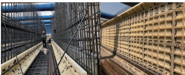
图 9 PVC 模板安装
