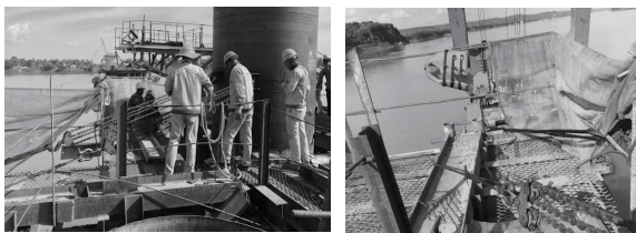
图 14 靠上游侧,通过 40# 工字钢焊接成整体后反拉纠偏
