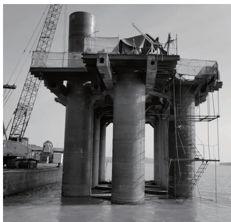
图4 下层平台露出水面,加长钢护筒
