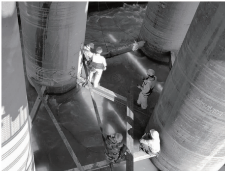
图 7 释放钢护筒在小平台受力
