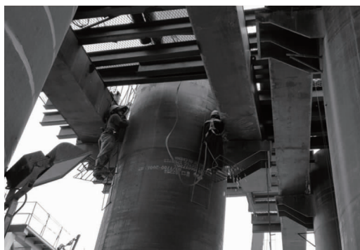
图5 解除护筒在上方平台限制
