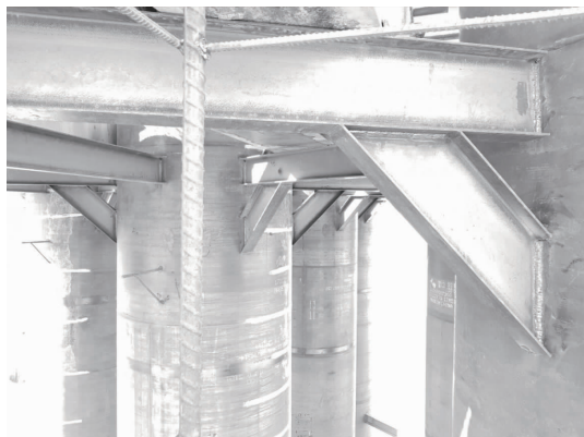
图 15 将工字钢焊在护筒上作为支撑牛腿
