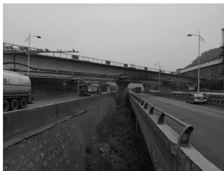
图10 中阳钢铁段现状断面实景
