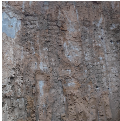
图7 现场基坑开挖图
