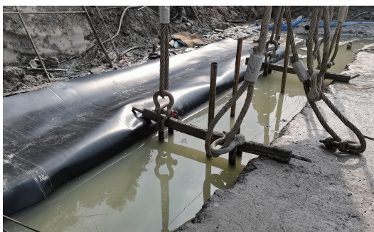
图6 附膜钢筋笼下放完成图
