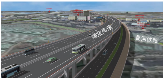
图 7 福宜高速主线和地面辅路跨越既有米轨示意图
