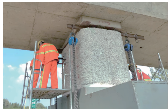
图10 钢盖梁安装现场
