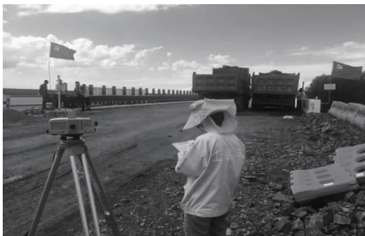
图 10 静载试验现场实景
