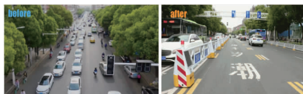
图11 岔路口片区金盛路潮汐车道
