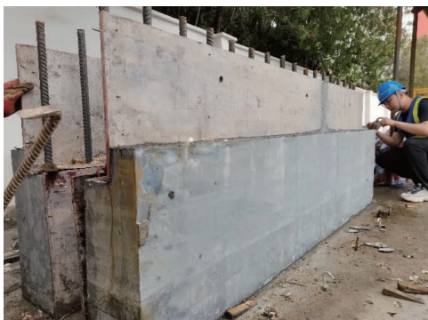
图9 UHPC湿接缝浇筑效果
