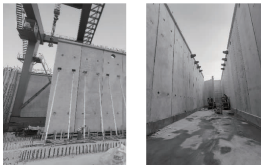
(a)预制墙体临时支撑及安装 (b)预制墙体安装完成效果
