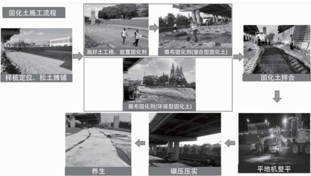
图 3 固化土施工流程示意图
