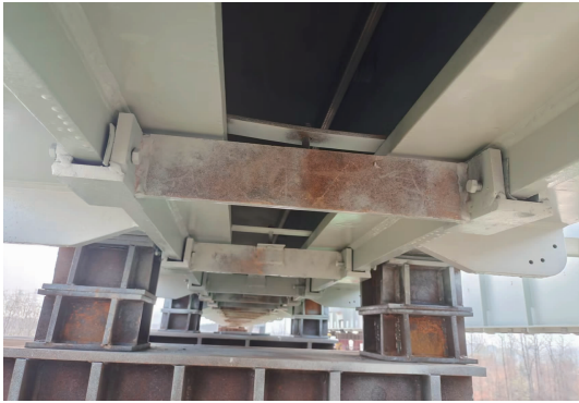
图 20 梁底约束装置安装效果图
