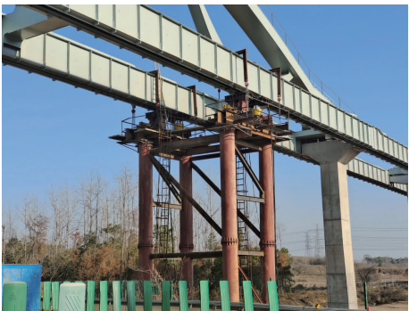
图 26 落梁装置安装效果图
