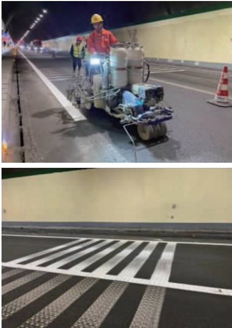
图 3 隧道覆线施工
