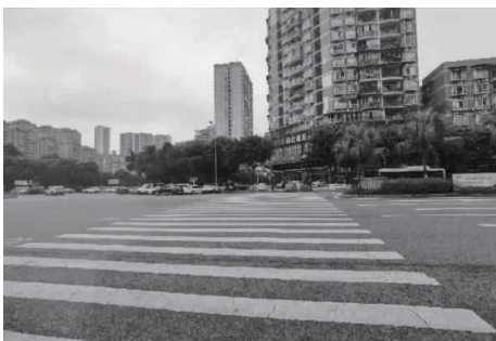
图5 龙山大道交叉口改造前
