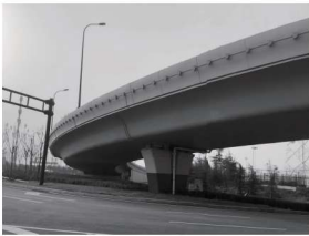
(b)钢箱梁建成实景
