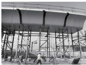
(a)钢箱梁施工照片
