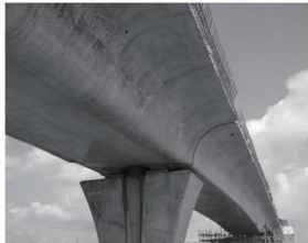
(b)箱梁断面顺接照片
