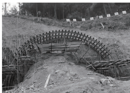
图5 洞口套拱管棚施工现场图
