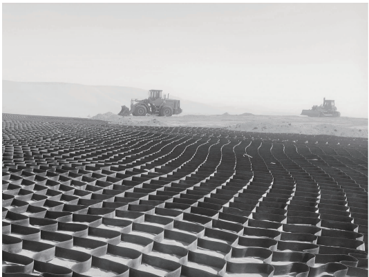
图 5 土工格室铺设
