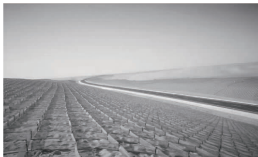
图9 低立式HDPE防沙方格网
