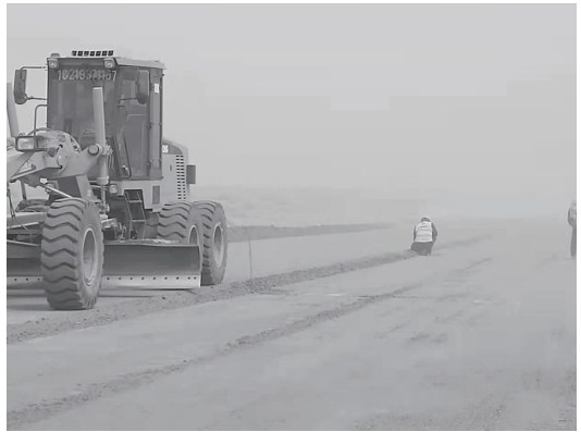
图 7 天然砂砾土摊铺整平
