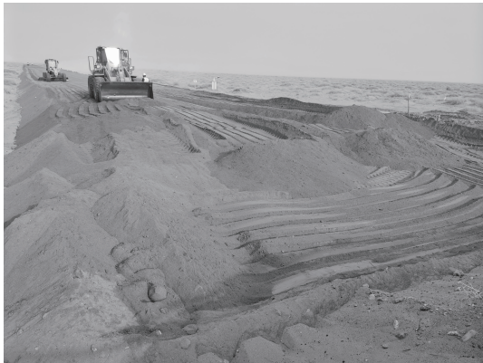
图 4 风积沙路基填筑
