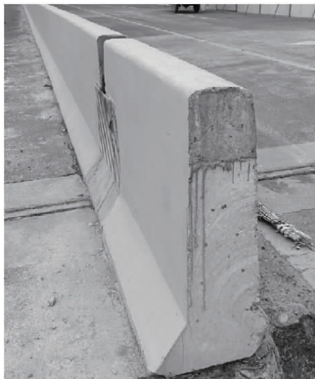
图 8 改造后 SAm 级钢筋混凝土护栏实际效果
