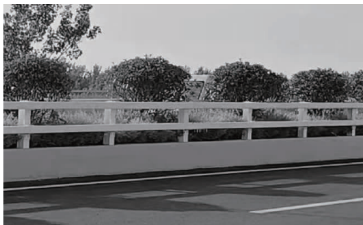
图 9 改造后 SA 级组合式护栏实际效果
