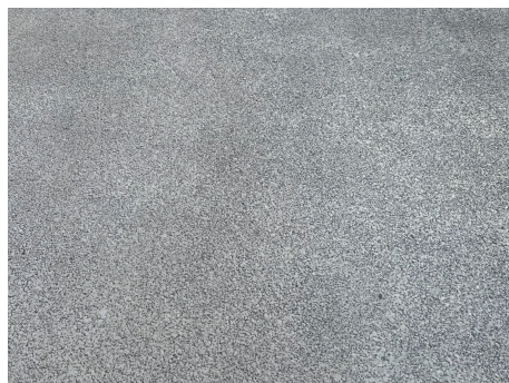
图4 空中连廊沥青桥面铺装现状
