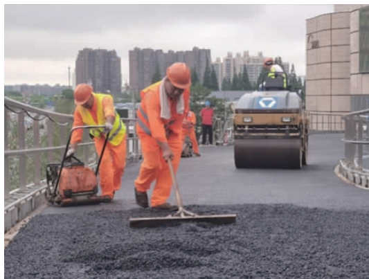
图3 桥面沥青混合料摊铺
