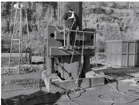
图 3 工人油顶上施工图
