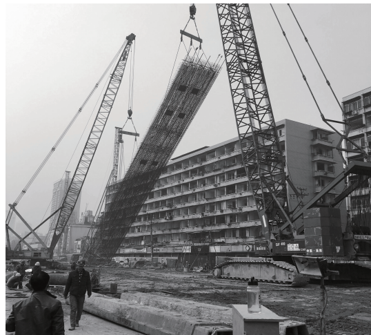
图1 双机抬吊施工图
