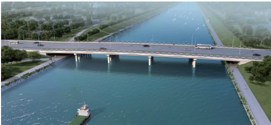
图3 先简支后结构连续方案效果图
