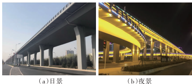
图 16 工程实景照片
