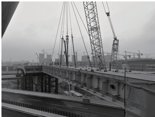
图 6 70 m 主跨大跨度无支撑悬吊拼接施工现场
