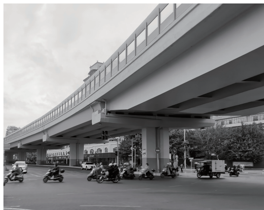
图2 路口钢混组合小箱梁建成实景 3.2 跨径布置 20~40 m 是目前国内城市快速桥梁的常规跨径,桥梁标准跨径的选择直接影响快速路工程总造价的经济合理性。表 1 对标准 18 m 桥宽平均墩高 8.5 m 单孔 25、30、35 m 跨度的高架结构在赣州章江新区典型工程地质条件下的主要工程量进行比较。
