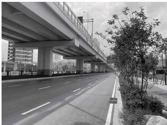
图1 预应力混凝土小箱梁建成实景 采用钢混组合梁 [1] 。 图2 为标准 18.0 m 桥宽大挑臂预应力盖梁 + 钢混组合梁体系的建成实景。
