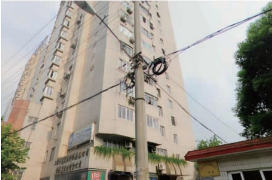
图 4 路口南侧金鹿大楼
