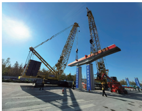
图 12 标准盖梁预制吊装施工
