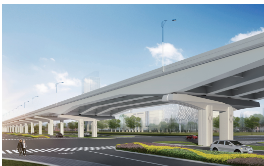
图3 跨路口折线底板组合梁方案效果图
