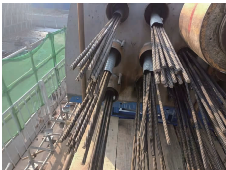
图 11 盖梁深埋锚工艺
