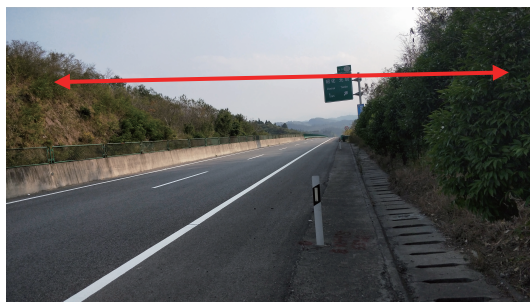
图1 桥跨现场情况
