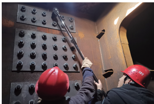
图8 腹板高强螺栓施工
