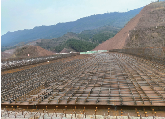
图 5 钢梁顶带孔钢板剪力键布置示意图
