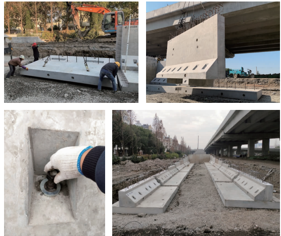
图8 施工现场照片
