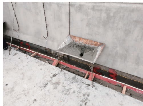
图10 预制防撞墙安装UHPC浇筑
