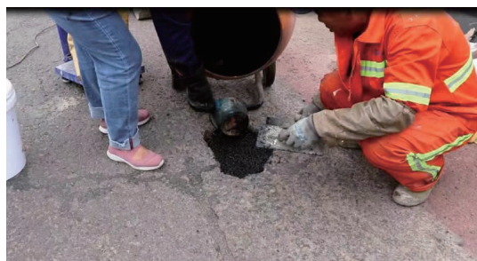
图4 冷补料修补坑槽
