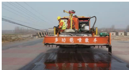
图5 喷撒含砂雾封层
