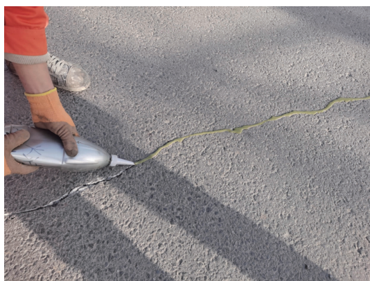
图3 常温牢巴路灌缝胶灌缝处理
