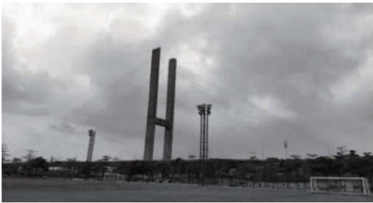
图 3 三水大桥立面照片
