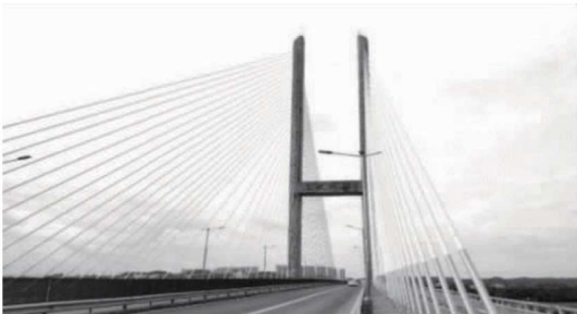
图 4 三水大桥桥面照片
