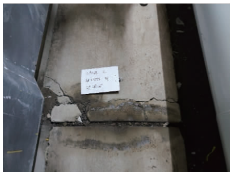
图 13 横向裂缝
