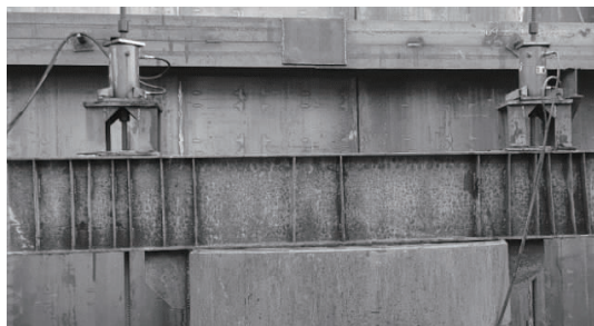
图 15 钢吊箱下放系统液压千斤顶
