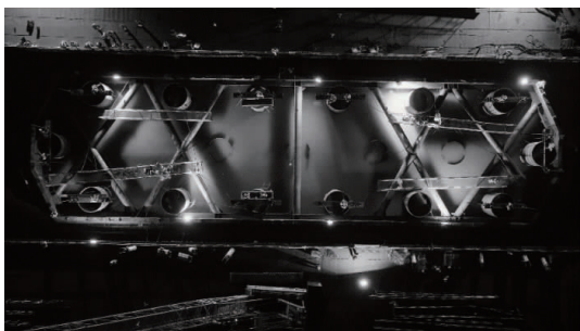
图 17 钢吊箱下放完成
