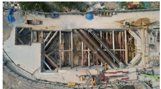
图1 深惠城际大鹏站-新大站区间围护结构航拍图
