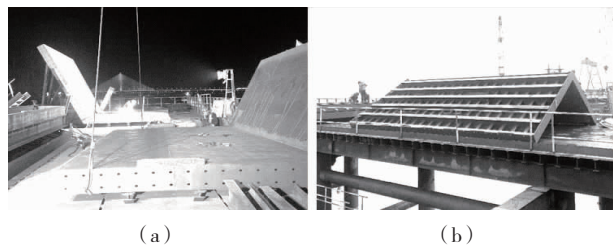
图9 钢吊箱侧板改制图
