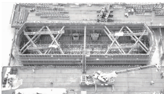
图7 钢吊箱拼装施工图
