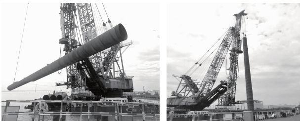
图 7 起桩、回转及立桩图
