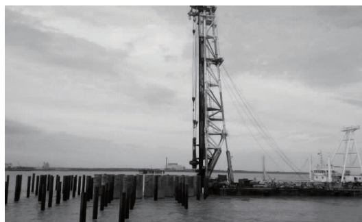
图 2 “路建桩 8”号打桩船
