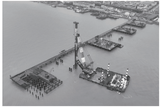
图 8 钢护筒沉桩施工图
