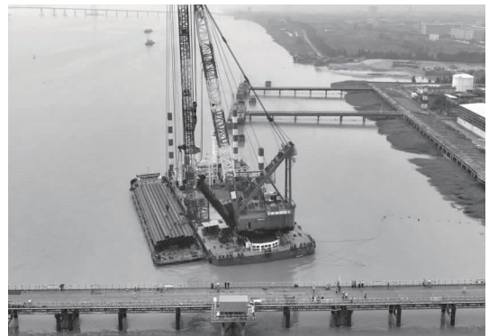
图4 运桩船靠泊打桩船
