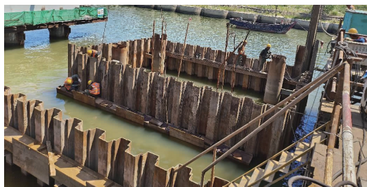
图6 钢板桩围堰施工示意图
