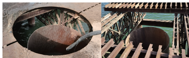
(a)钢护筒下沉偏位 (b)钢护筒下沉
