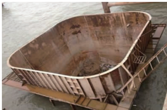
图7 钢套筒围堰施工示意图
