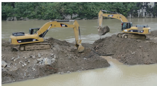
图5 土围堰施工示意图
