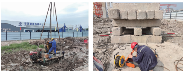
图 4 粉喷桩取芯和单桩承载力检测图
