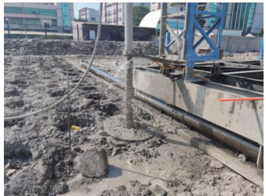
图3 桩顶洒水增加土层含水量图
