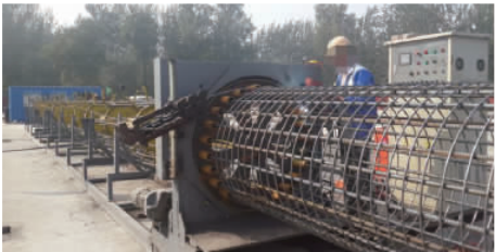
(b) 钻孔灌注桩钢筋笼
