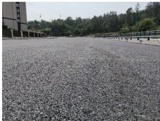
图2 冷拌冷铺混合料现场外观图
