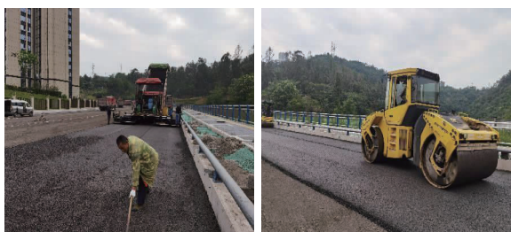
图1 混合料的摊铺和碾压现场照片
